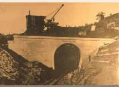
Der Autunnel im Bau
