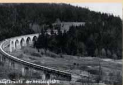
Bauplan und Ausführung des Wettbachtalviadukts
